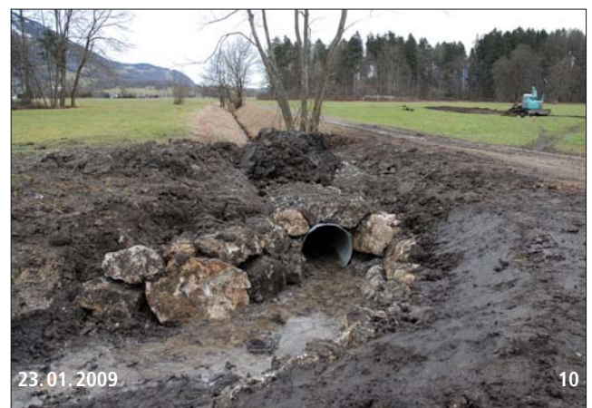
Bild 3: Vorne die noch nicht geöffnete Röhre des eingedolten Forstbachs. Bild 4: Der grösste der ausgehobenen Steine wog gegen 3 Tonnen. Bilder 6–12: Bau des neuen Durchlasses für die Zufahrt auf das Grundstück Nr. 1082.
