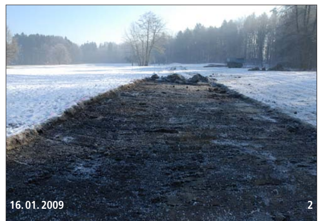
Abtrag der Humusschicht, die für Planierungsarbeiten auf der Projektfläche oder in deren unmittelbaren Umgebung verwendet wurde. Bild 1 Ansicht von Osten, Bild 2 von Westen.
