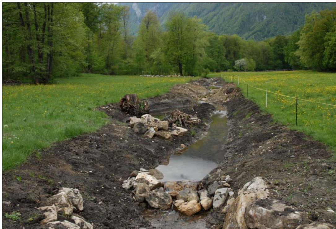
Blick auf den östlichen Teil des Grundstücks Nr. 1078 mit dem im Januar 2009 entlang der Grundstücksgrenze geöffneten Abschnitt des Forstbachs. (Stand am 30. April 2009).
