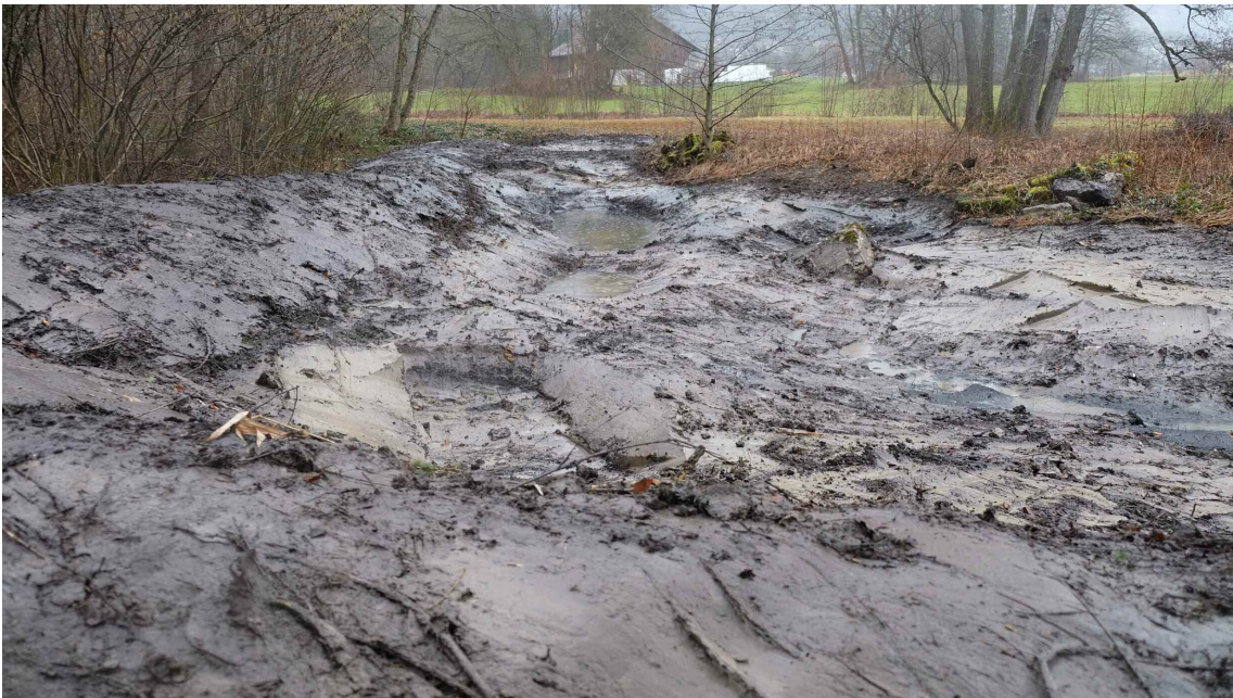
Forst, 16. Januar 2018: Die östliche Teichgruppe unmittelbar nach den Baggerarbeiten für die Tieferlegung.
