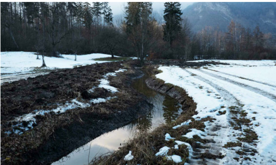
Am 3. Februar 2017 waren die Arbeiten bis auf die Feinplanung abgeschlossen. Diese wird erst möglich, wenn das Material gänzlich aufgetaut und abgetrocknet ist.
