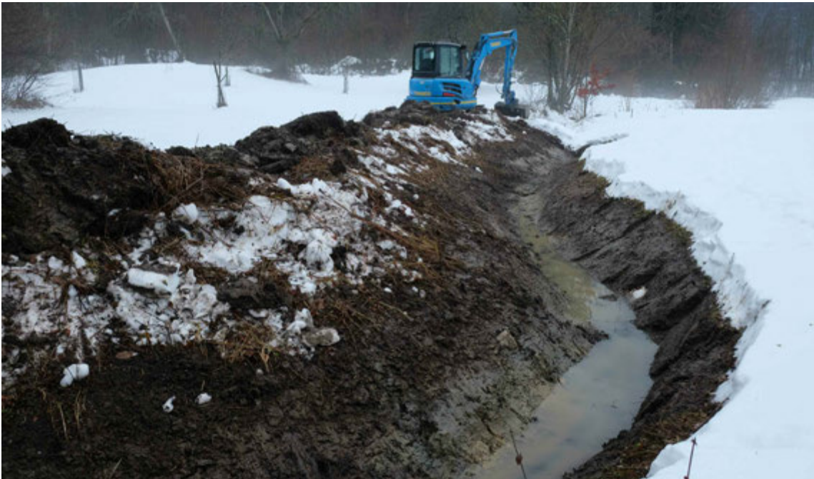
Das Schwärzibächli am 31. Januar 2017 während den Ausbaggerungsarbeiten.
