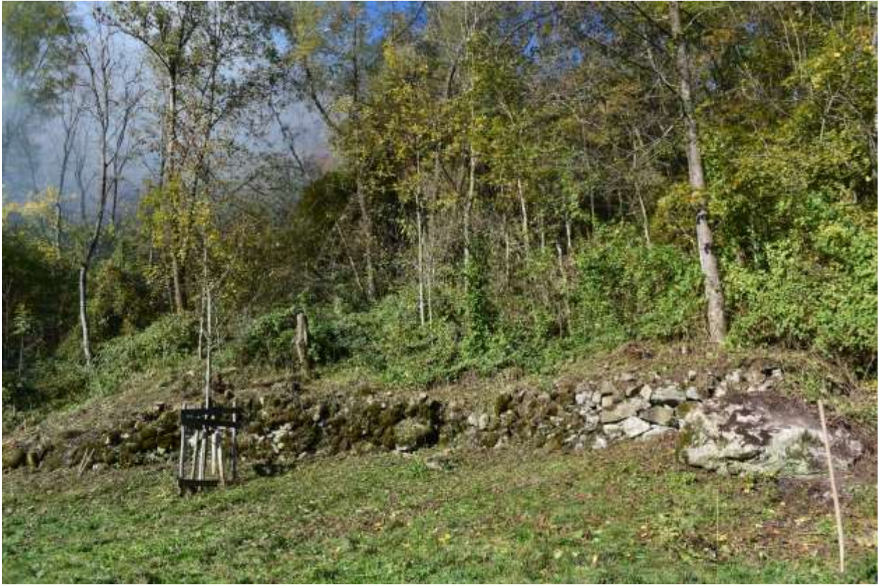
Abbildung 3 Naturstein-Mauer nach ausgeführter Arbeit
