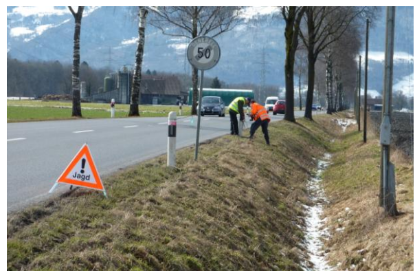
Kurt Düsel und Georg Frei bei der Montage der Wildwarner
